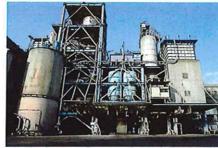
混合プラント
